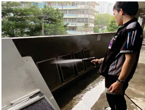
การดูแลความสะอาดเครื่องปรับอากาศส่วนกลาง ภาพที่ 2.2-3 ระบบปรับอากาศและระบายอากาศ
