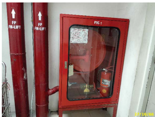
ท่อขึ้น และตู้เก็บสายฉีดน้ำดับเพลิง
